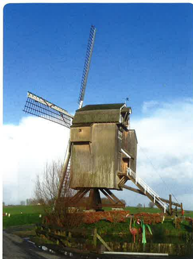
Le moulin de Moulbaix est un moulin en bois pivotant entièrement sur son axe, d'abord érigé à Blicquy avant d'être transféré à Moulbaix, non loin d'Ath, en 1747...
